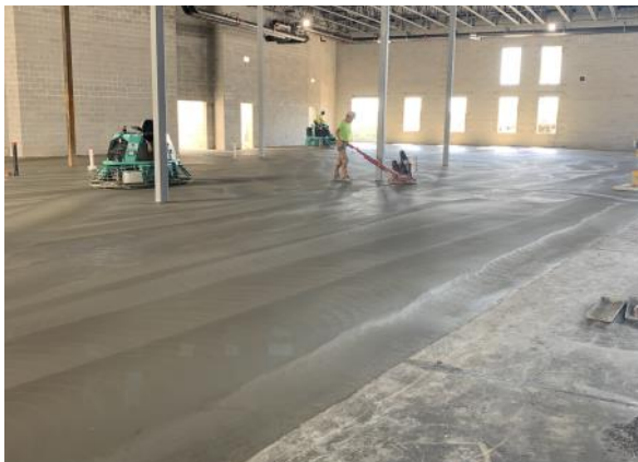
Band area concrete floor pour (08/23/2022)
